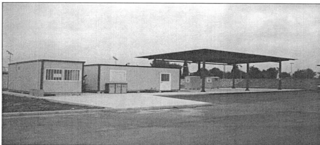
Figura 19: Centro raccolta differenziata dei materiali
