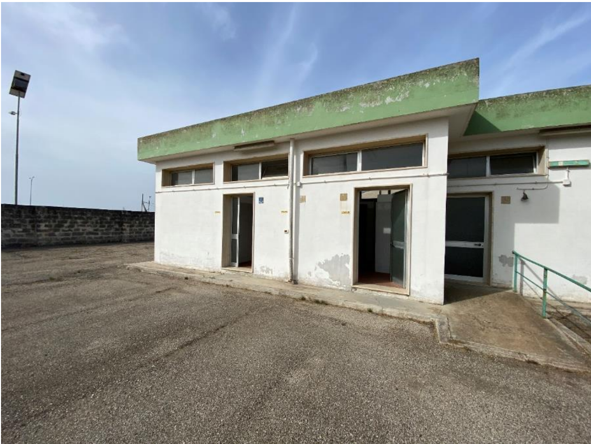
Foto 8: Blocco Servizi Ovest.
